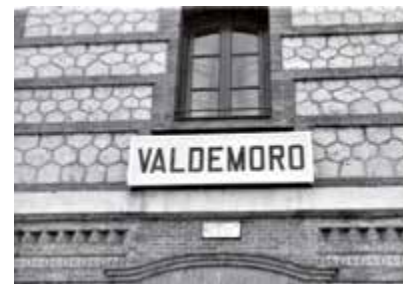
Cartel anunciador en la fachada de la estación. 1973. Archivo Municipal de Valdemoro
